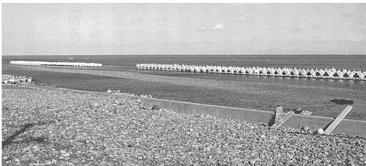
大岩地区の離岸堤
