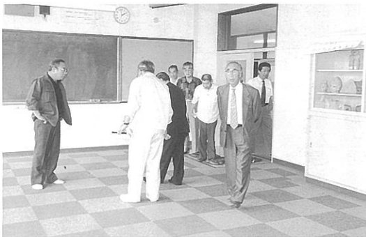
中学校 S F 教室改修工事
