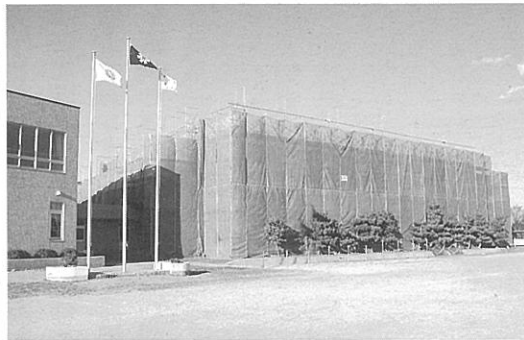
小学校屋体外壁改修工事
