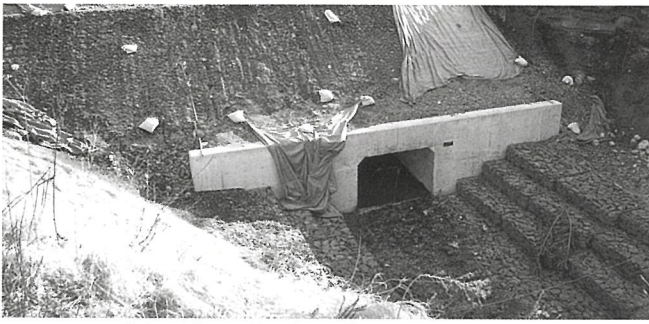
ザリ石川に設置されたボックスカルバート
