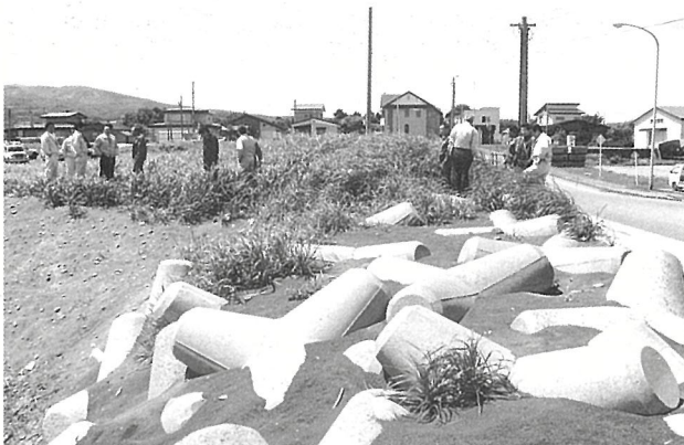
本別東護岸（旧防波堤）
