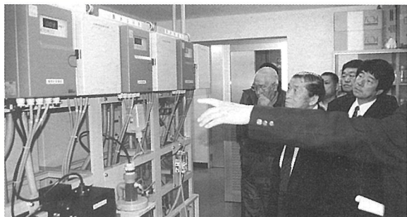
浄水場施設内
