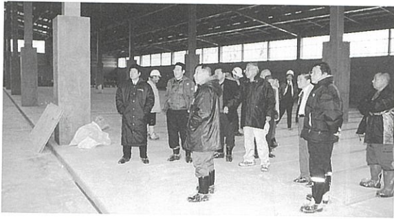
建設中の漁業系廃棄物リサイクル施設 (現在は完成し稼働中)
