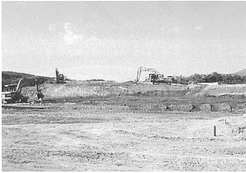
建設のため整地された土地
