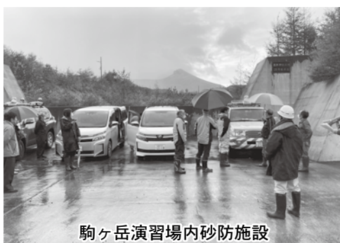
駒ヶ岳演習場内砂防施設（調節池）
