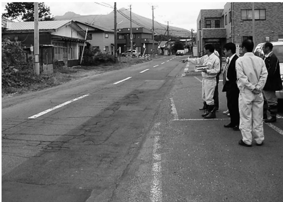
舗装改修工事前の町道本別海岸線（本別中央会館前）
