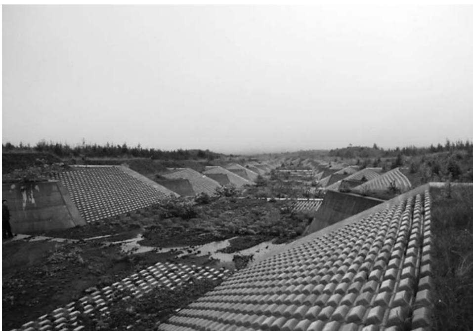
駒ヶ岳演習場内に整備された床固工
