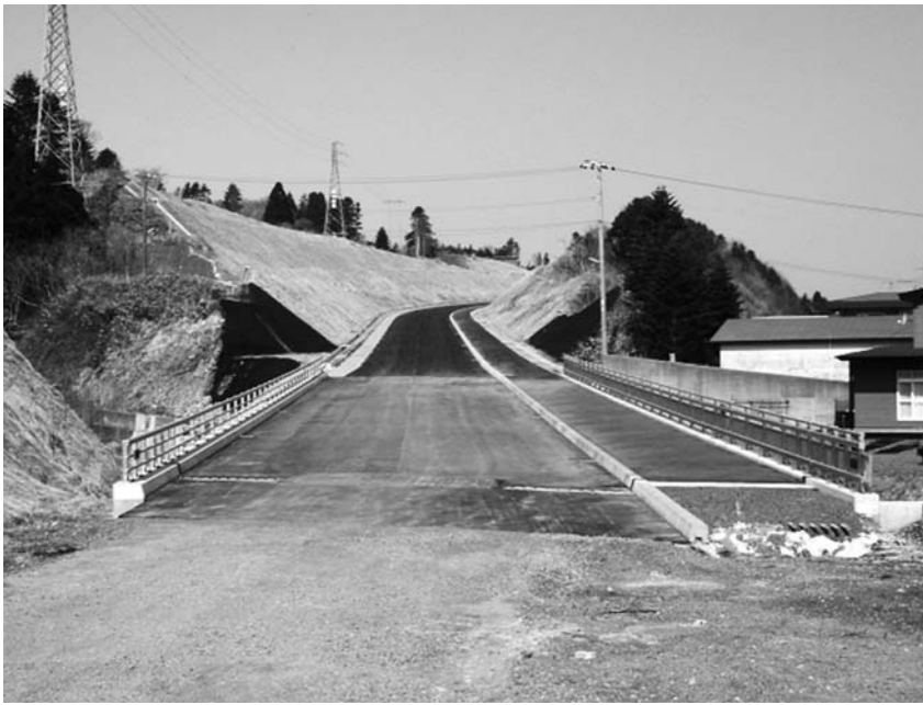
一部供用開始されている鹿部バイパス (大岩常呂川付近)
