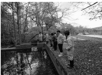
鹿部川上流の取水施設
