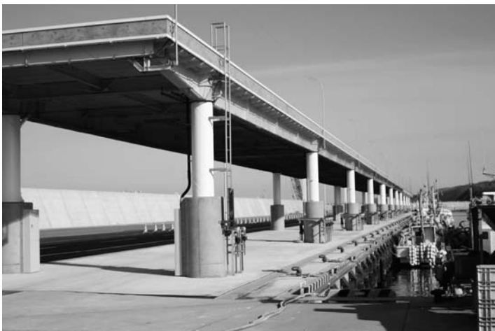
鹿部漁港取排水施設
