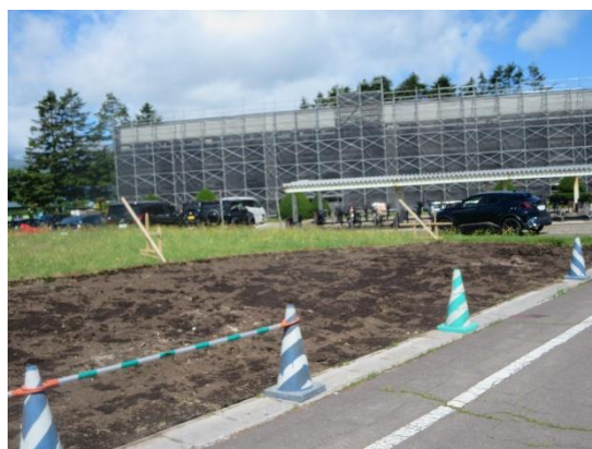
〈 7.16 駐車場になる土地の工事 〉
