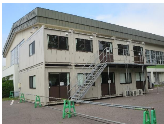
〈 7.02 体育館裏に工事業者の事務所が作られる 〉
