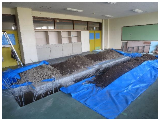
〈 8.13 新理科室の水回り工事 〉
