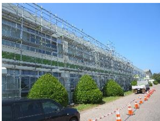
〈 6.24 工事用の足場が組まれる 〉
