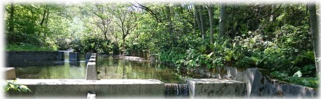
写真 鹿部川 取水施設付近の状況
