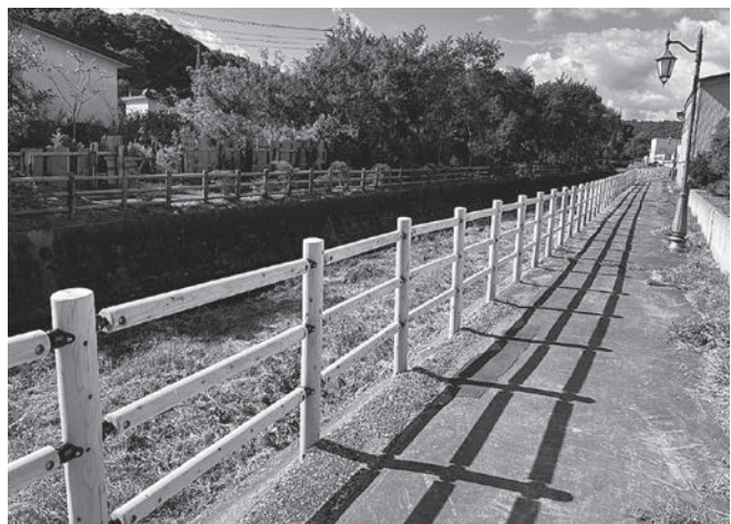
昨年に引き続き、せせらぎ散歩道転落防止柵の改修を行いました。
