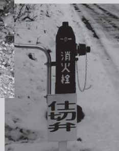
消火栓改修後
