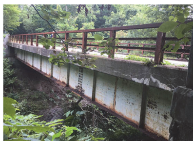
尻無川橋(橋長24.51m) 昭和33年供用開始(64年経過)
